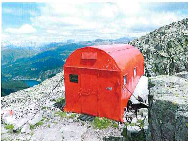
Il Bivacco Aldo Moro nei pressi delle Cime di Ceremana
